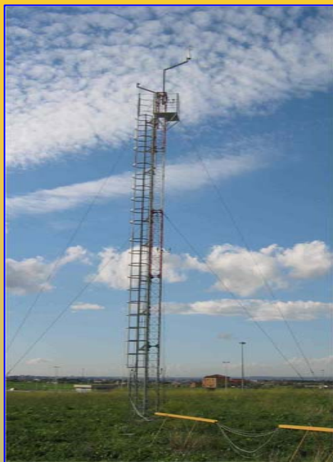
La torre meteorologica alta 15 m puo' essere strumentata a diverse quote con anemometri sonici, sensori di temperatura e umidita'.
