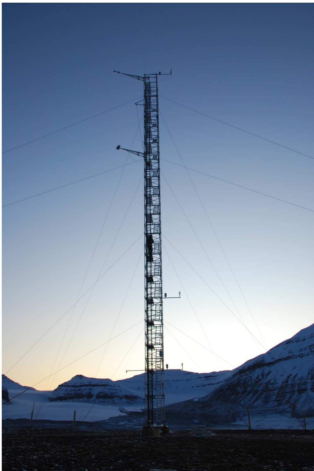
La CCT in fase di allestimento
