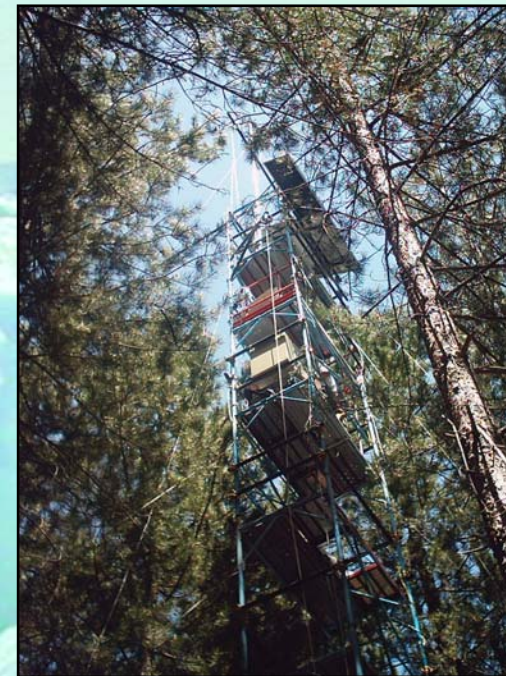
Infrastruttura per la misura dei flussi di carbonio, vapore acqueo ed energia fra ecosistemi forestali e atmosfera, installata nel Parco Nazionale della Sila. (Foto fornita da Giuseppe Scarascia Mugnozza)
